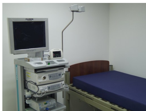
Imagen de los equipos de endoscopia FUJIFILM instalados en la sala de endoscopias.
